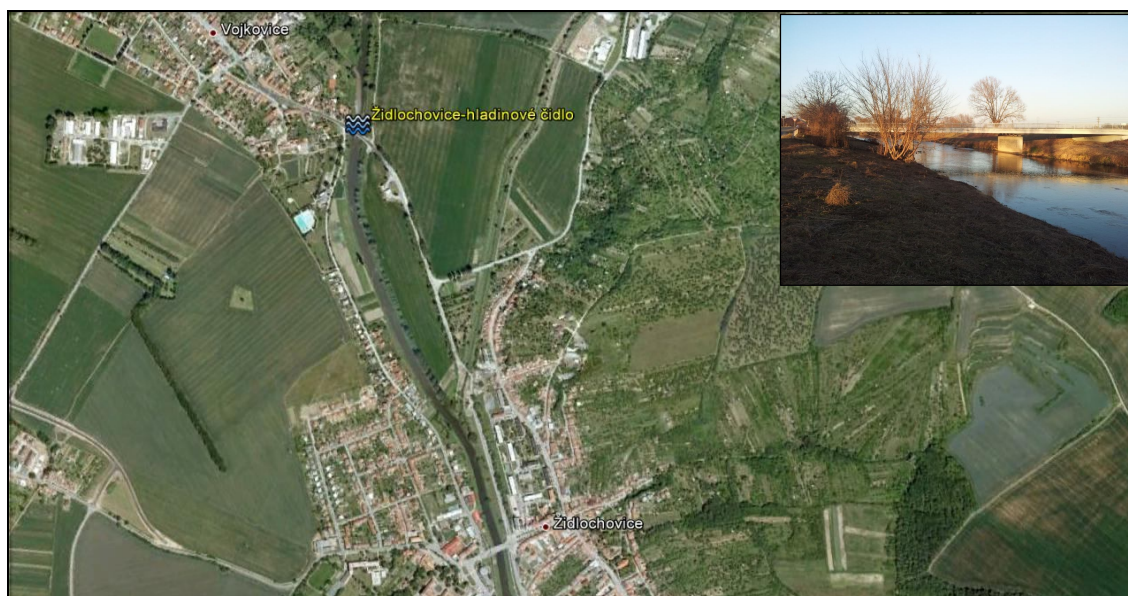
Umístění hladinoměru a vodočetné latě ve Vojkovicích na mostě přes řeku Svatku
